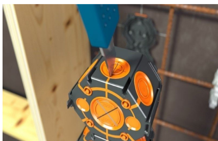
Otevřete membránu odlamovacím nožem.
